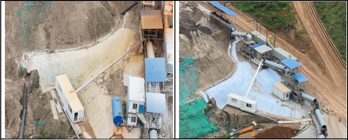
临时苫盖现状
