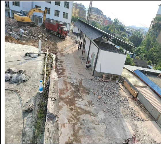
硬化区域需要维修处理的区域现状（2024 年 11 月）：目前为混凝土硬化，表面有破损，水土流失强度总体呈微度。
