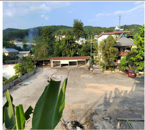
硬化区域需要维修处理的区域现状（2024 年 11 月）：目前为混凝土硬化，表面有破损，水土流失强度总体呈微度。
