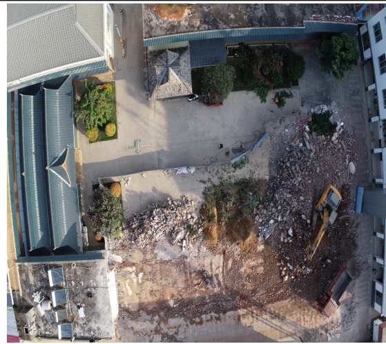
正在拆除的原门诊楼（2024 年 11 月）：拆除区域四周采用彩钢板进行围挡，拆除的建筑垃圾采用随拆随运的方式进行运输，水土流失强度总体呈强度。
