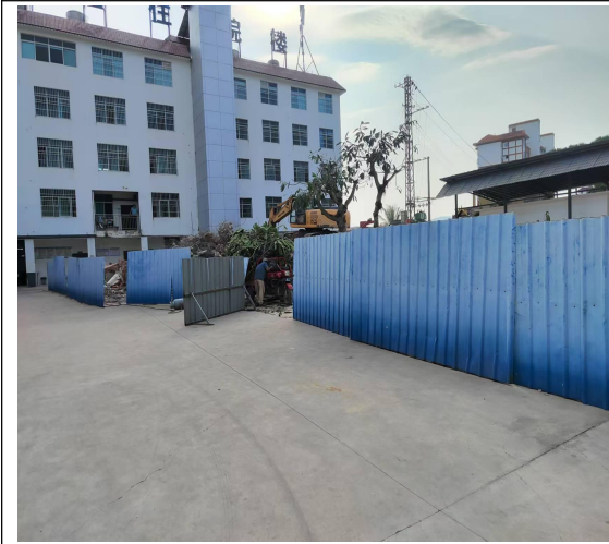
正在拆除的原门诊楼（2024 年 11 月）：拆除区域四周采用彩钢板进行围挡，拆除的建筑垃圾采用随拆随运的方式进行运输，水土流失强度总体呈强度。
