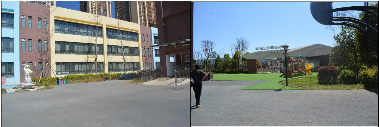
项目区道路及场地现状情况
