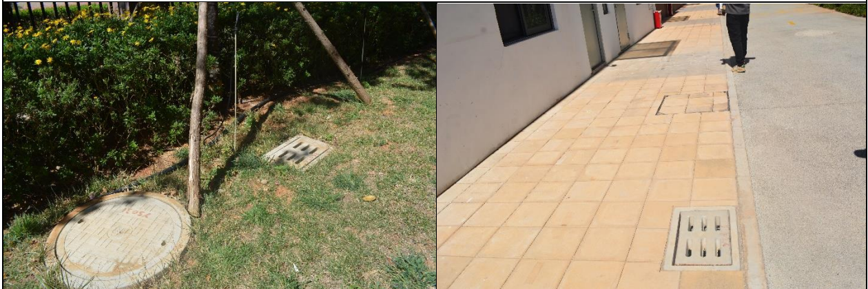
项目区雨水口及检修井现状情况
