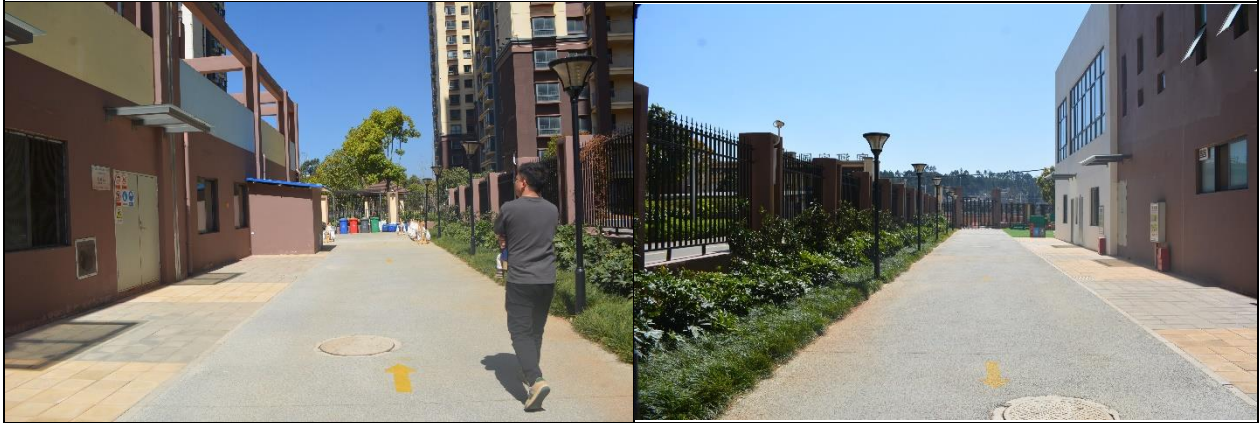
项目区道路及场地现状情况
