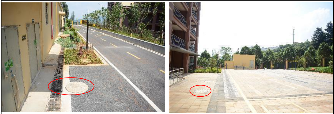
雨水管网及排水沟实施现状
