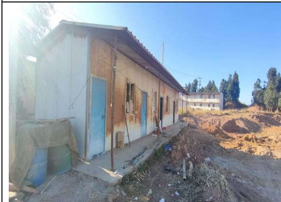
施工临时仓库用房（2023年12月）
