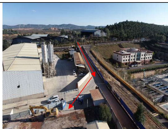
外部道路及出入口（2023年12月）
