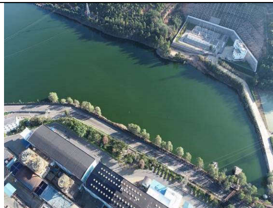
拟处理雨水现状（2023年12月）
