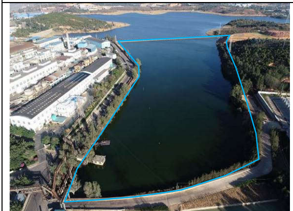
70万 m 3 雨水收集池现状（2023年12月）
