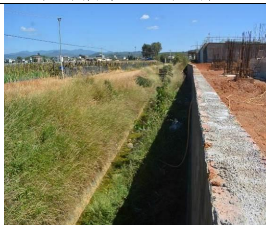
北侧新兴苴水库西沟现状 (2023 年 11 月)
