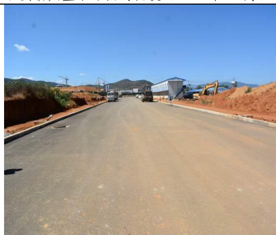
南侧市政道路 (2023 年 11 月)
