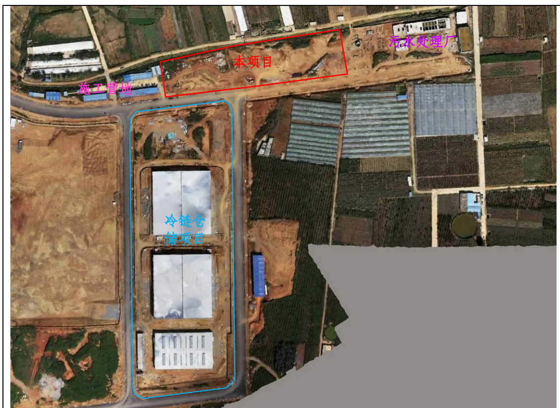
项目及周边现状正射影像（2023年11月）
