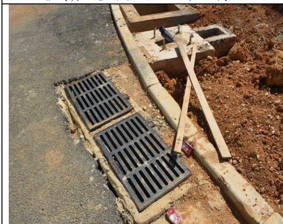
外侧市政路雨水井 (2023 年 11 月)
