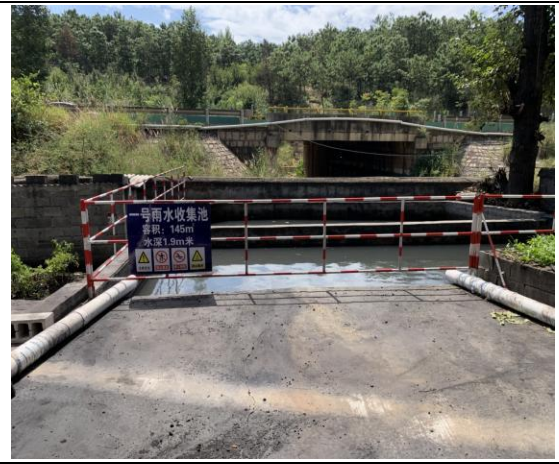
项目区南侧雨水收集池：容积 145m 3
