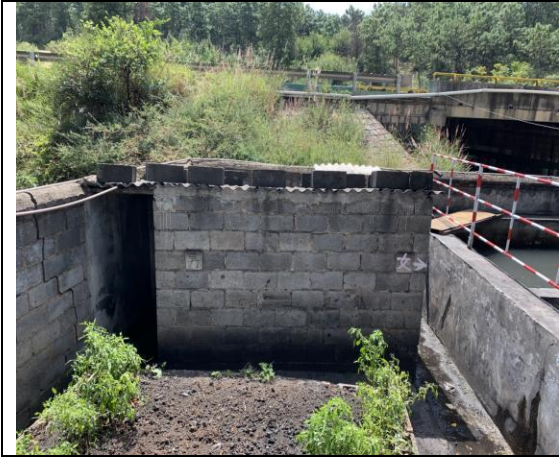
厕所 2 现状：单层砖混结构
