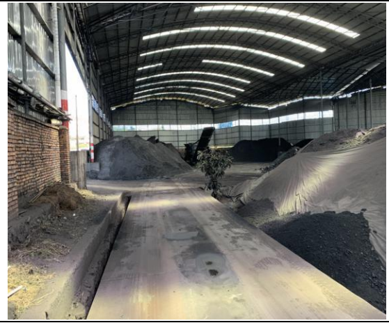
2#钢棚内部现状：堆放有各级别精煤
