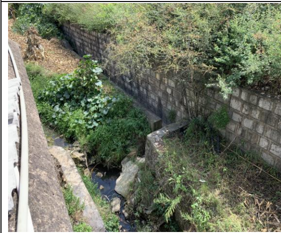
项目区南侧红线外已有的灌溉沟渠
