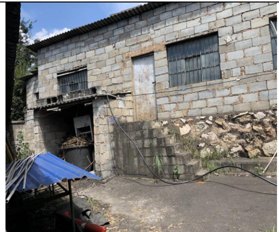
仓库现状：单层砖混结构
